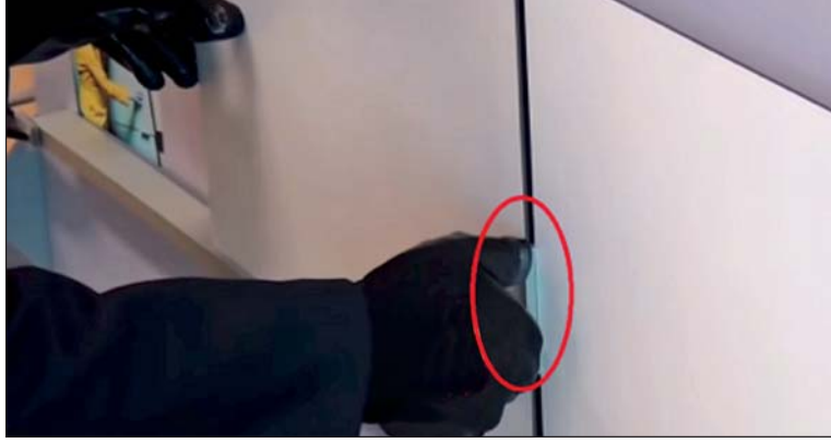
Yapıştırma işleminde boşluk bırakma
